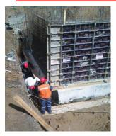
Revêtement d'étanchéité monocomposant à base de polyuréthane et de bitume pour étancher les points singuliers et les parties difficiles d'accès. La membrane durcit sous une forme continue et élastique, comme une couche totalement adhérente. Cette couche garantie une étanchéité totale et résiste aux mouvements du bâtiment.
