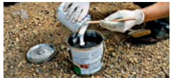
Het uithardingsmiddel in de basis gieten
