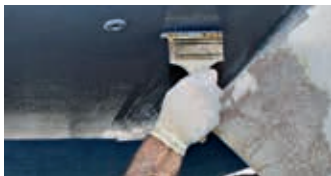
Hempel's High Protect II met een kwast in tegengestelde richting opbrengen
