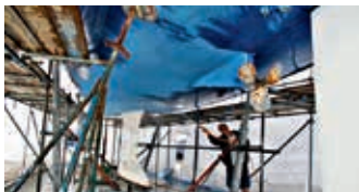
Geschuurd oppervlak reinigen
